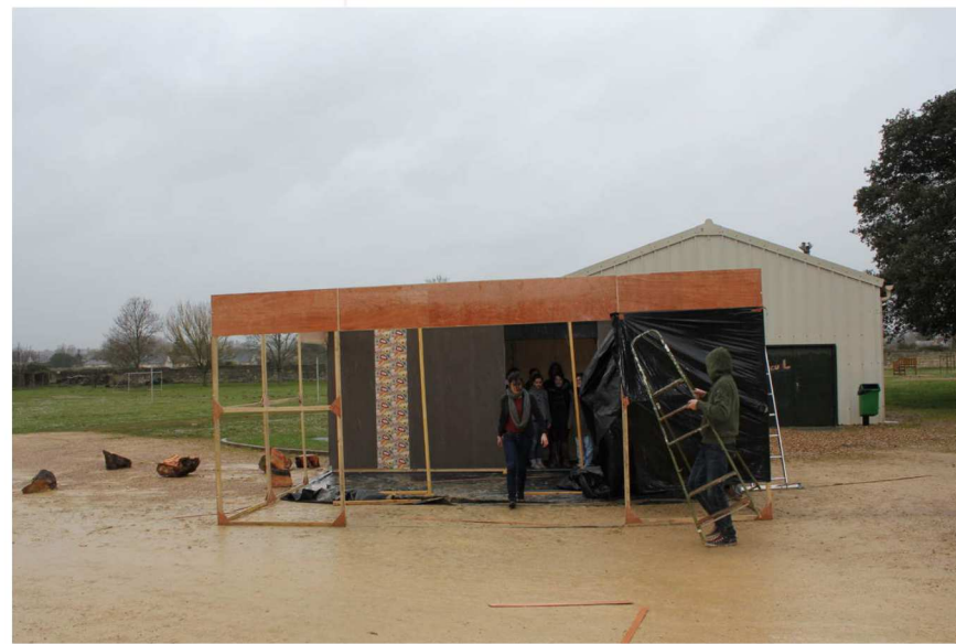
Sous la pluie, dans le vent,... mais on avance quand même!
